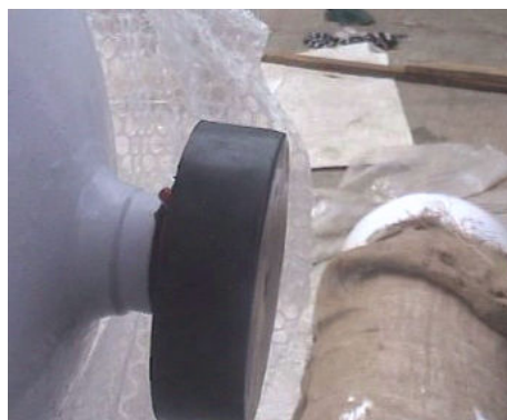
شکل ۱-۴: نصب پوشش محافظ بر روی شیر مخازن
